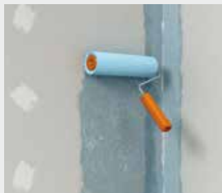
Afb. 18: fermacell Diepgrond aanbrengen op het hele oppervlak
