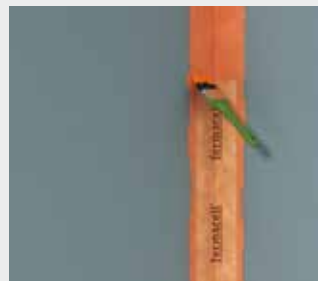
Afb. 19b: ...en meteen afsmeren met Vloeibare folie
