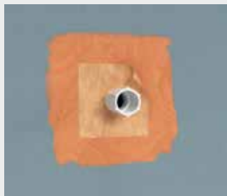
Afb. 20: Voor fermacell wandmanchet
