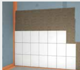
Afb. 22: Bij gebruik van Powerpanel H 2 O platen binnen woonsituaties. Tegels worden in een dunne laag fermacell Flexibele tegelijm geplaatst (garandeert de afdichting voor de vochtbelastingsklasse A01).
